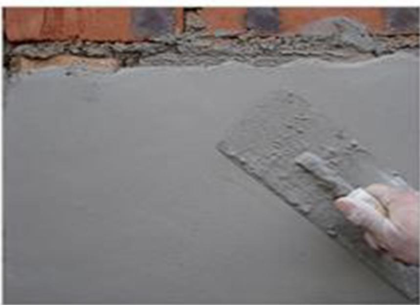
阳离子氯丁胶乳防水砂浆是采用一定比例的水泥、砂并掺入水泥量10%~20%（以固体含量计）的阳离子氯丁胶乳、一定量的稳定剂、消泡剂和适量的水，经搅拌混合均匀配制而成的一种具有防水性能的聚合物水泥砂浆。阳离子氯丁胶乳防水砂浆由于乳液均匀地分散在材料中骨料的表面上，在一定温度条件下，逐步完成交联，使橡胶、骨料、水泥三者相互形成橡胶骨料网络膜，封闭了材料中的毛细孔道，从而使砂浆起到防水抗渗的作用。阳离子氯丁胶乳防水砂浆适用于地下建筑物和水箱、水池、水塔等贮水设施的防水层，屋面、墙面防水防潮层，建筑物裂缝的修补等工程。氯丁胶乳防水砂浆是由水泥、砂、氯丁胶乳以及表面活性剂（稳定剂、消泡剂）组成。水泥采用，砂以粒径在3mm以下并经过筛的洁净中砂为宜。
