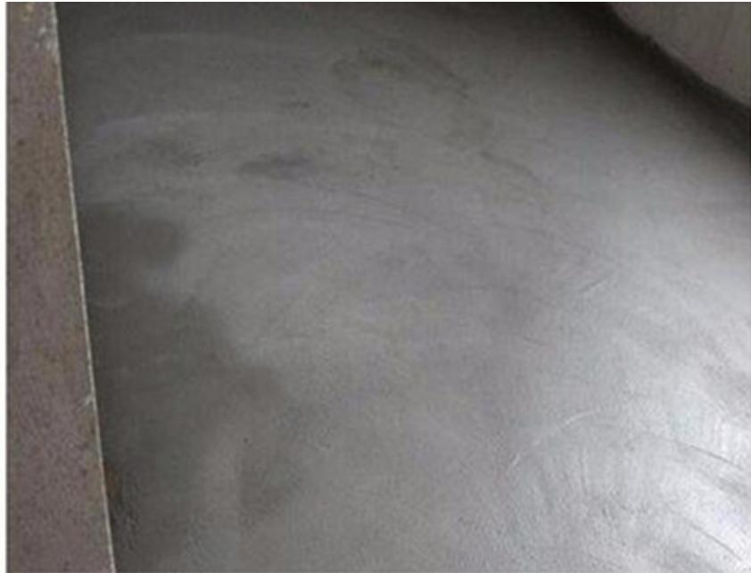
防水砂浆施工工艺。1、清理干净基面并洒水湿润，但应无积水。2、用防水剂与水泥（重量比1: 2）搅拌成素灰浆，在施工部位涂刷密实，厚度 $\square\square\text{br}/\square3\square$ 待表干后（约30分钟）用防水剂与水泥、砂子（重量比1: 2: 6）搅拌成砂浆，以普通抹灰方式施工即可，抹灰厚度为6-15毫米。4、防水砂浆层凝固后（可上人）约20小时按正常砂浆洒水养护。注意事项：1、搅拌素灰浆或砂浆过程中，不得另加水或其它液体。2、适合用，砂子含泥量应低于3%，含水量应低于15%。3、防水砂浆要抹平压实，不得有空隙裂纹，地漏、穿管、卫生洁具的根部、铺设冷热水管的凿沟内为重点防水施工部位，要细致做好，阴阳角部位应做成R角。
